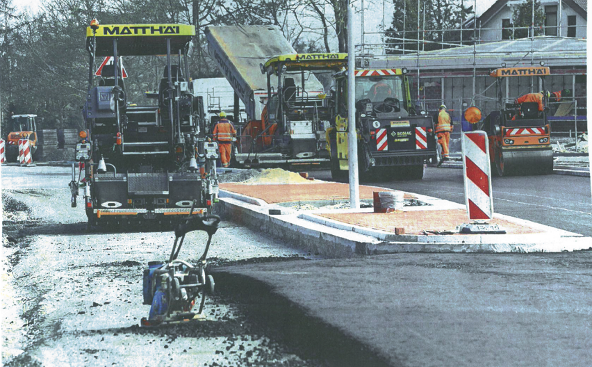
Bauarbeiter asphaltieren die Cherbourger Straße im Norden der Stadt – bald soll der Verkehr hier rollen.
