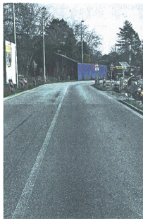
Die provisorische Fahrbahn wird noch bis 2023 bestehen bleiben – als Bauplatz für die Eisenbahnbrücke über der Langener Landstraße.
