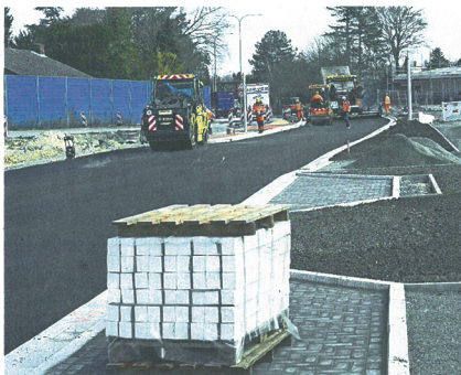
Die Pflaster- und Kantsteine sind schon verlegt.
