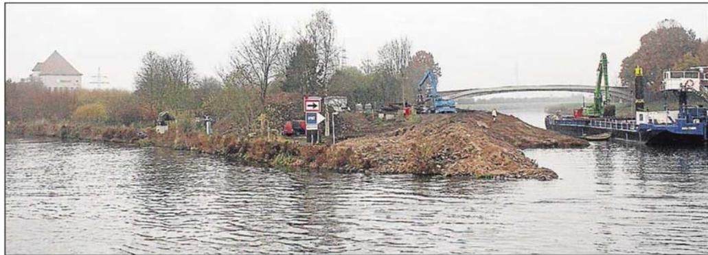
Links im Bild die Weser mit dem Wasserkraftwerk, rechts der Kanal Richtung Schleuse. In der Mitte, am ehemaligen „Palm Beach“, wird derzeit ein beachtliches Stück der Kanalspitze, zirka 9 200 Kubikmeter Boden, abgetragen. ▪ Foto: Raczkowski
