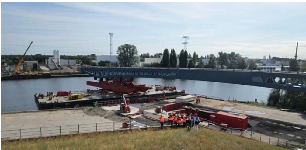
Erster Stahlüberbau für die neue Spreebrücke im Zuge der Süd-Ost-Verbindung (SOV) wird über die Spree geschoben.
