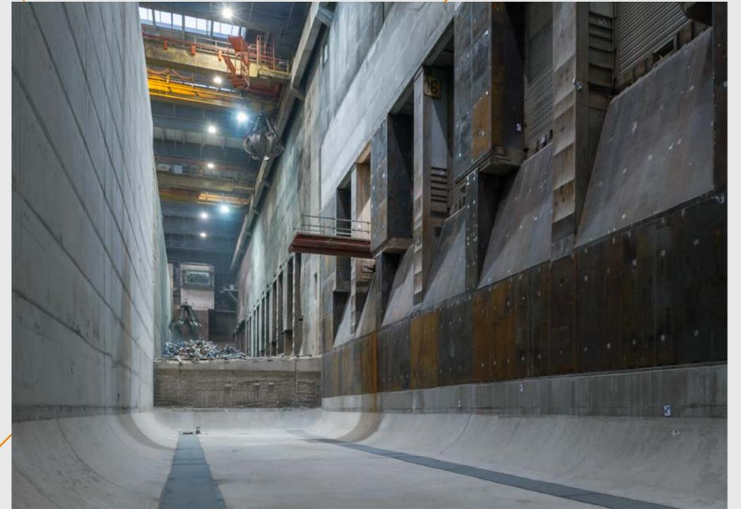
**Die Sanierung und Verstärkung des inneren Bunkers einer Berliner Müllverbrennungsanlage stellte höchste Anforderungen an Planung, Technologie und Material. Für die Arbeiten an den Innenwänden des Müllbunkers kam ein rollbares Baugerüst auf Schienen zum Einsatz, wodurch die Arbeitseffizienz stark erhöht werden konnte. Zudem wurde durch eine 1.026 m<sup>2</sup> Trennwandkonstruktion der Fortbetrieb des anliegenden Bunkerteils gewährleistet.**
