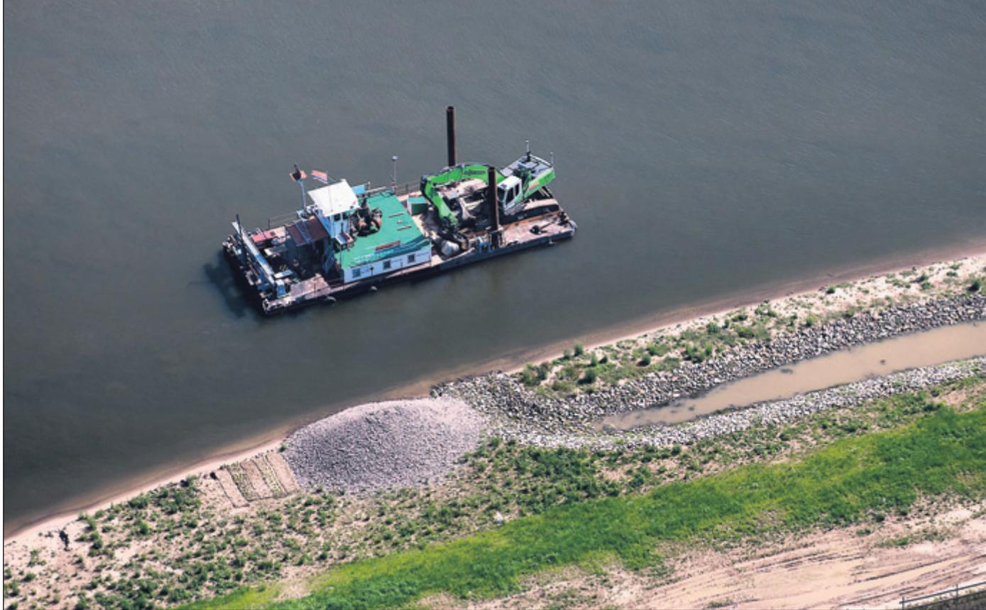
Mit Hilfe von Pontons, auf denen auch sogenannte Umschlagbagger Platz finden, werden Uferbereiche zurückverlegt.
