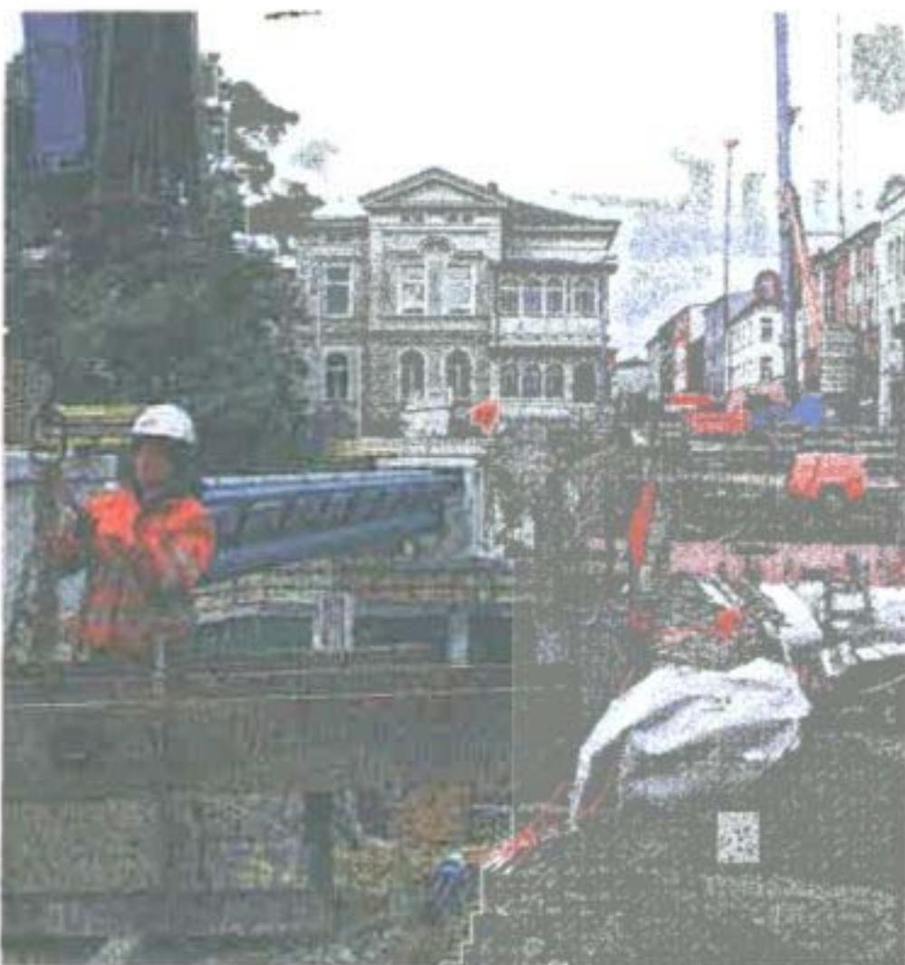
Geschafft: Die Stützen der Baugruben konnten gestern entfernt und das Brückenbauwerk an den Seiten mit Kies hinterfütert werden.
