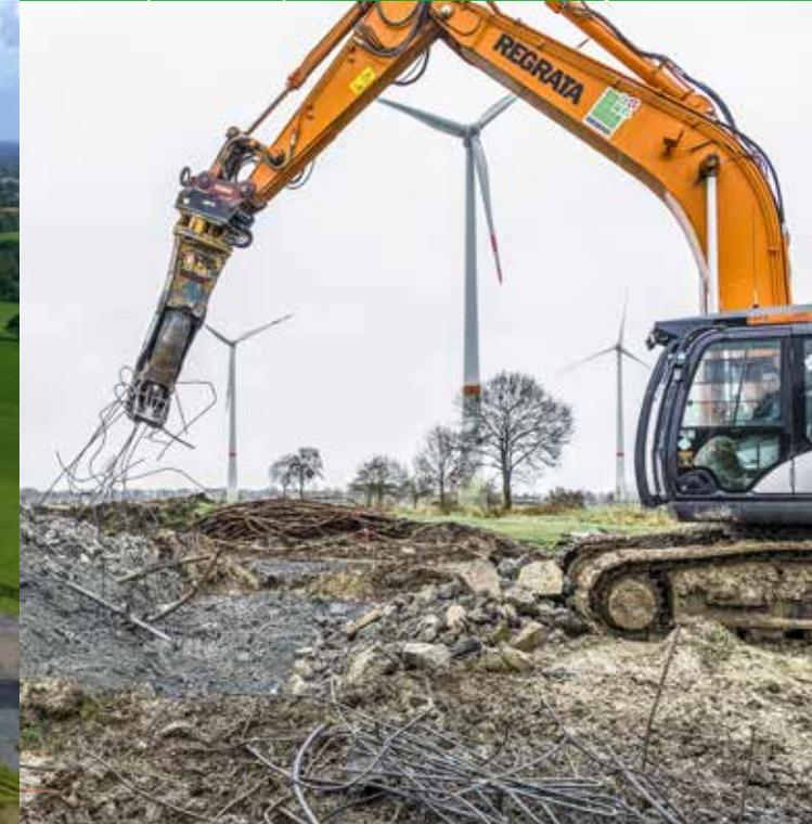
Abbrucharbeiten an einer ausrangierten Windkraftanlage durch Regrata
