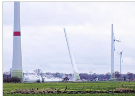
Rund 2,5 Kilogramm Sprengstoff wurden benötigt, um die alte Anlage im Windpark zu Fall zu bringen.
