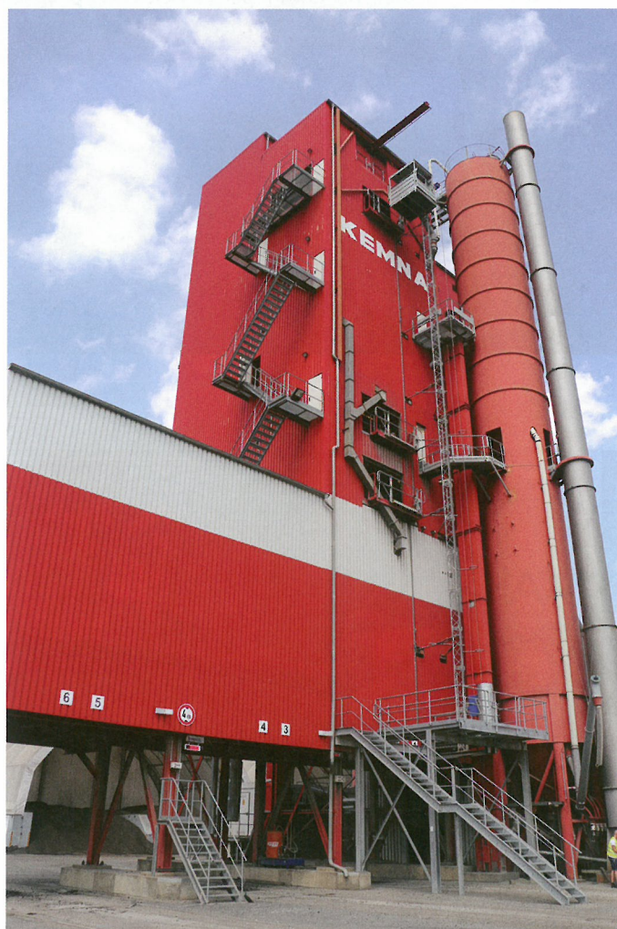
Das Asphaltmischgut wurde im Asphaltsplitt-Werk Anderten der Kemna Bau in Hannover produziert.
