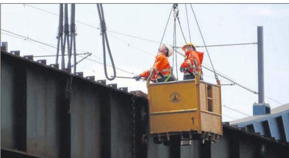
Die beiden Arbeiter legen den tonnenschweren Stahlträger an die Kette.
