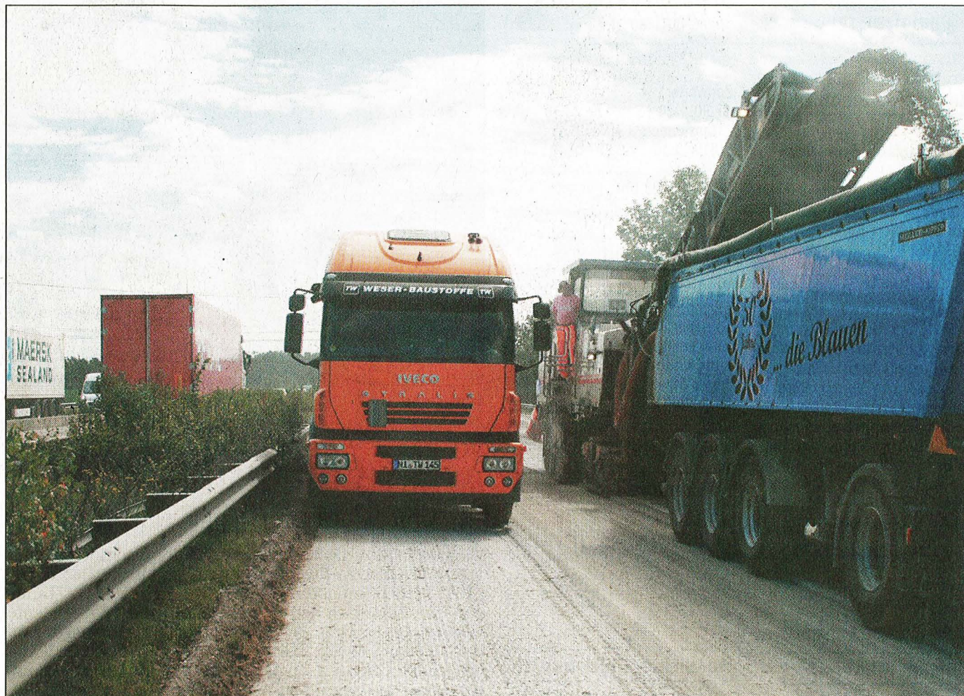
105 000 Quadratmeter Beton in einer Stärke von elf Zentimetern werden derzeit von vier Spezialmaschinen abgefräst. ■ Fotos: Koy
