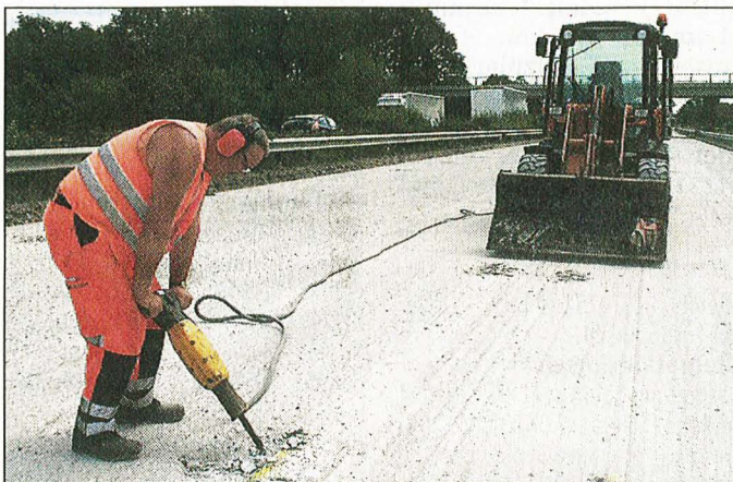
Auch Handarbeit ist auf der Baustelle A 27 gefragt.
